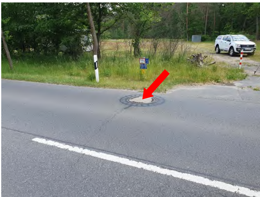
Bild 4: Ansicht auf den HPB am 06.06.2023, Blickrichtung: Südosten
