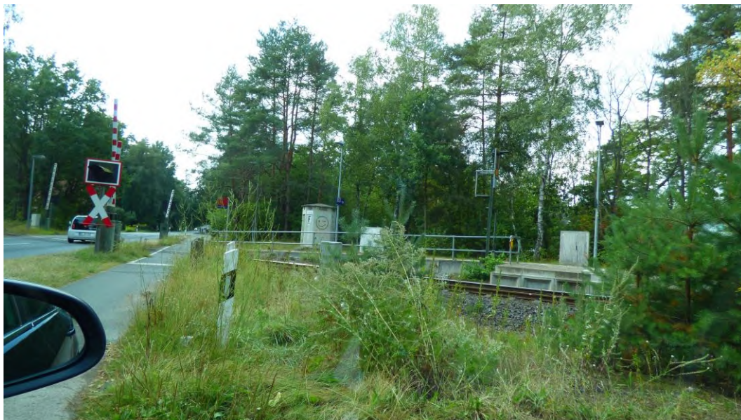
Ausfahrt P+R-Parkplatz, Blickrichtung Südwest
