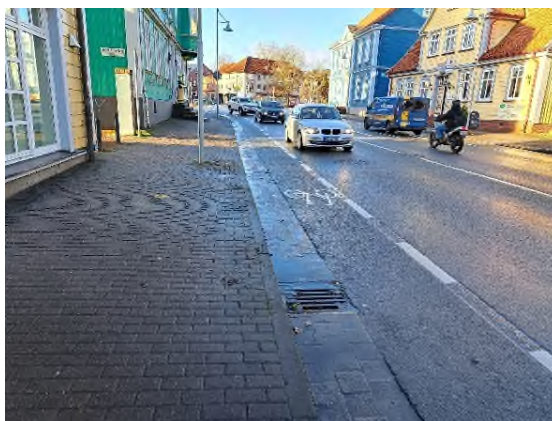
Abbildung 25: Schutzstreifen in der Poststraße
