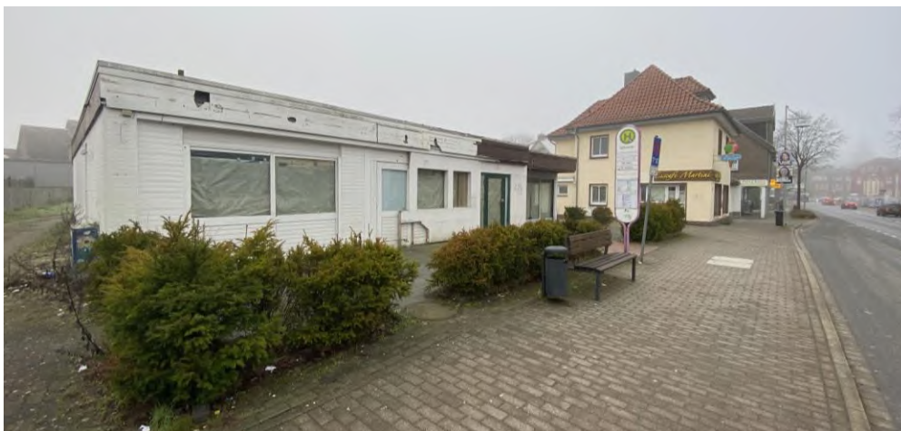
Abbildung 7: Leerstehende Immobilie in der Wilhelmstraße 14
