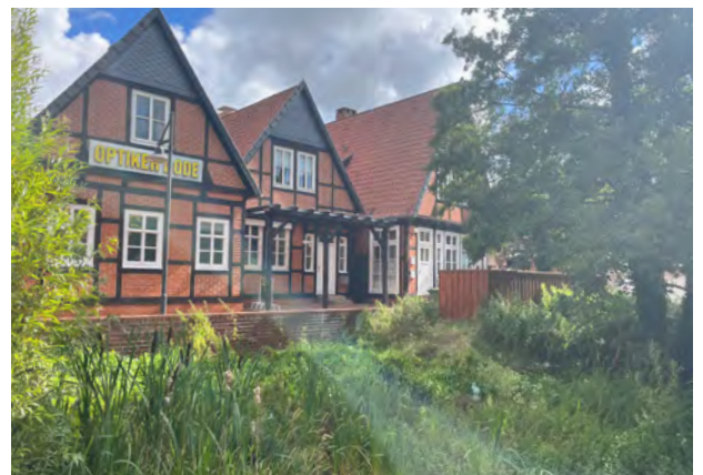
Abb. 25 Zugewucherter Bereich der Soltau, Neuer Hagen
