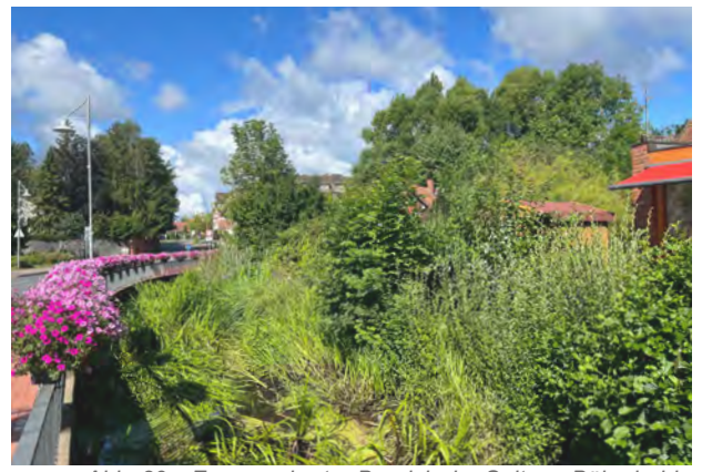
Abb. 29 Zugewucherter Bereich der Soltau, Böhmeide
