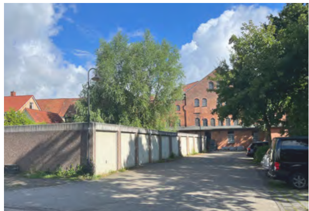
Abb. 20 Garagen im rückwärtigen Bereich, felto Gebäude
