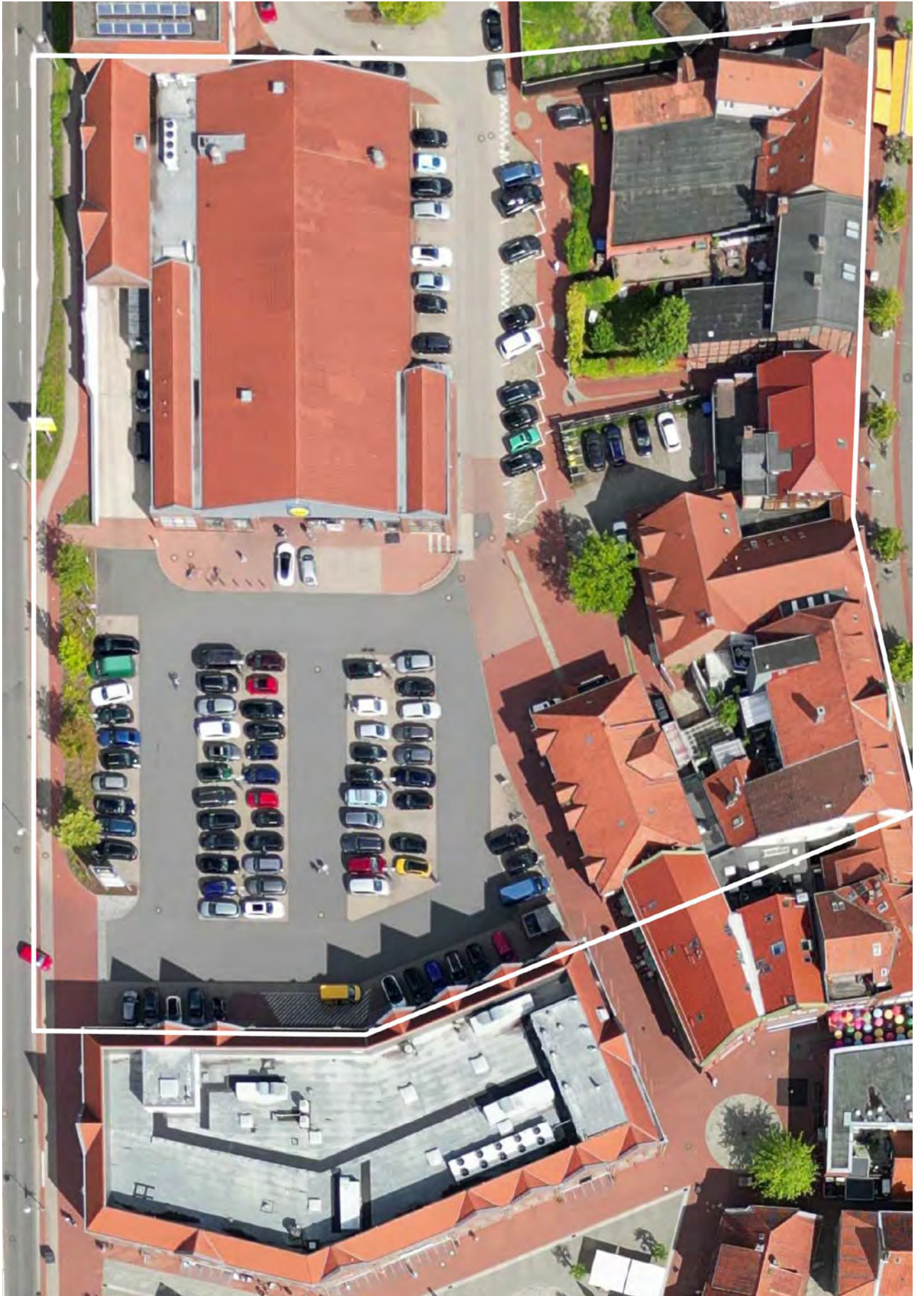
Abb. 60 Luftbild Am Alten Stadtgraben
