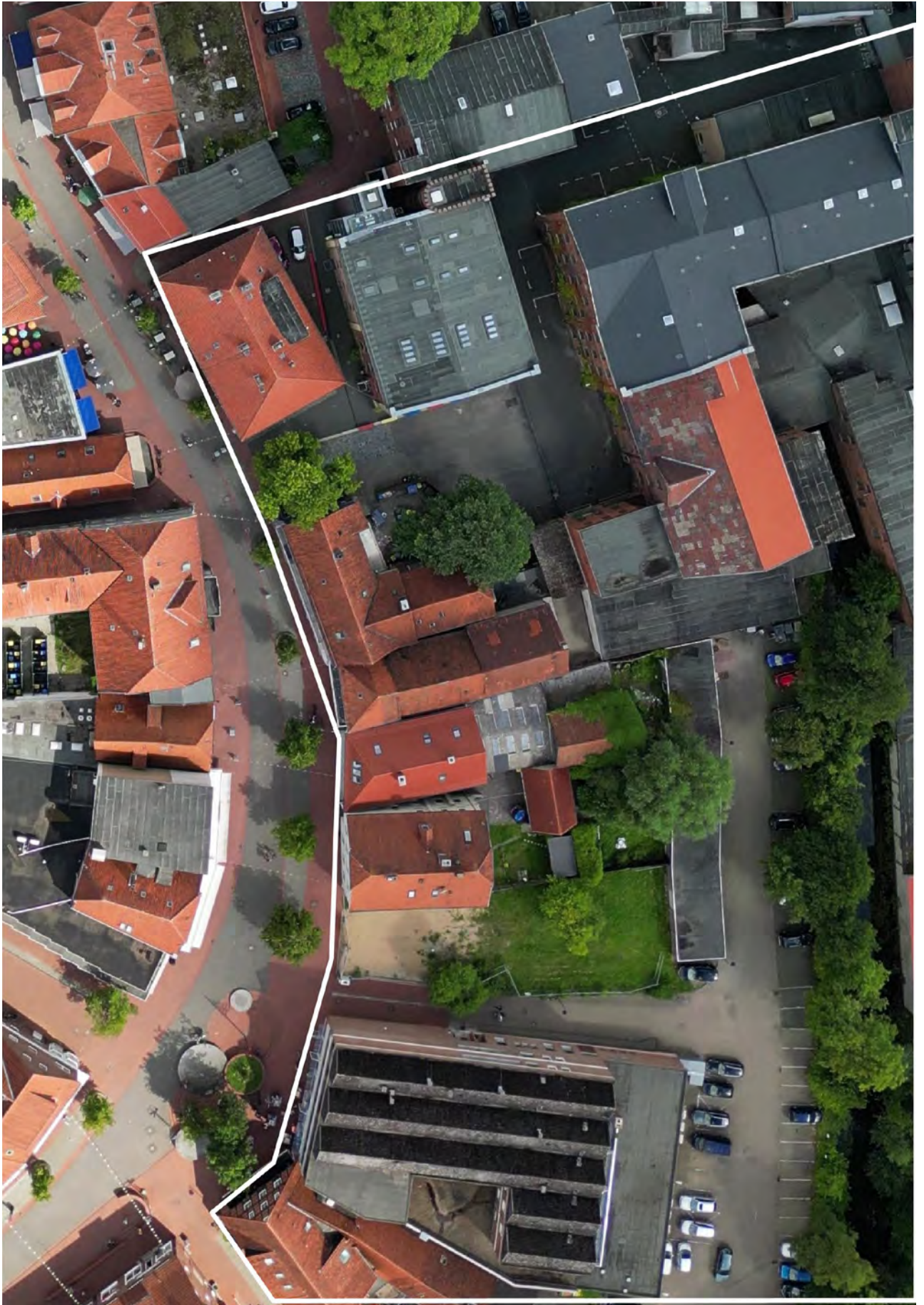
Abb. 55 Luftbild Am felto Gelände
